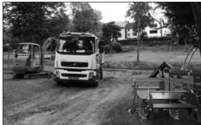
Ein Bagger hebt die Fundamente aus, die ersten Spielgeräte sind schon geliefert
